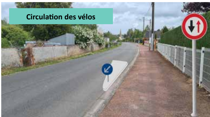
Mise en place du sens unique
